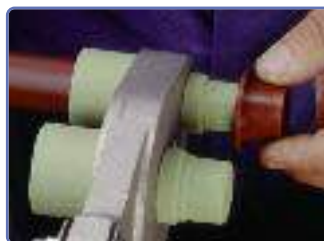
Fusione el buje al tubo.
