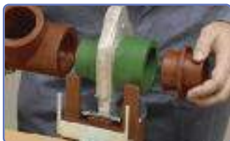
Fusione el niple entre-fusión al accesorio.
